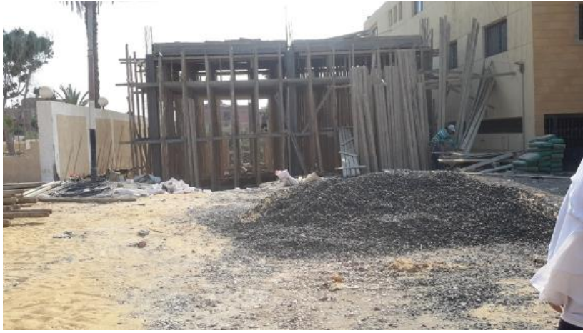
صورة (٢١) مركز اسعاف تحت الانشاء - حياة كريمة
