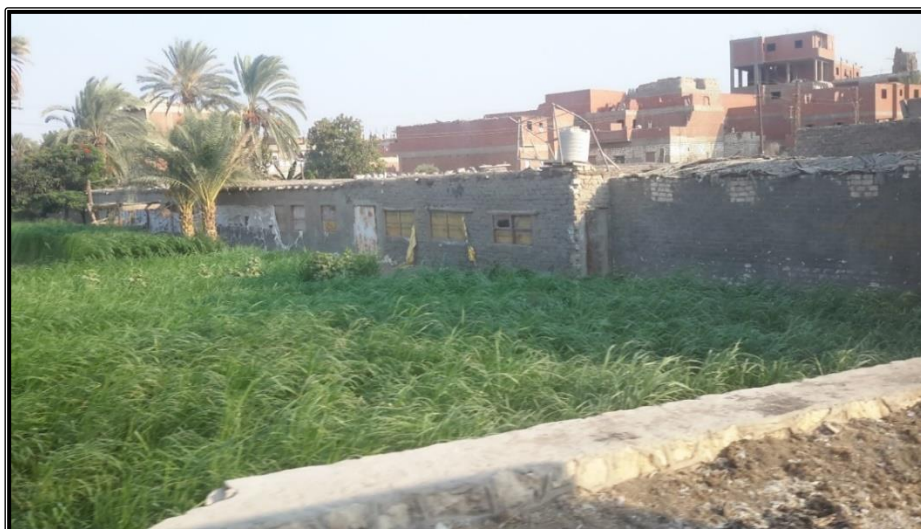
صورة (٦) مساكن من أطوب الطوب الني وأسقف الجريد
