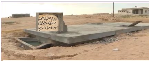
صورة (٤) خزان لحجز المياه ( مبادرة حياة كريمة في مطروح أغسطس ٢٠٢١
