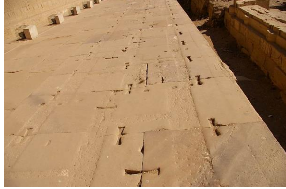
(لوحة ٨) كتل مربوطة بمعبد دندرة باستخدام تشييق ذيل الحمامة
