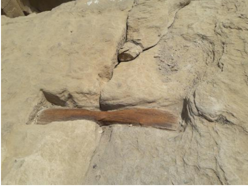
(لوحة ١٠) تشييق ذيل الحمامة المثبت في مكانه حتى الآن بمعبد كوم أمبو. تصوير الباحث
