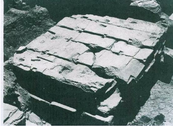
( لوحة ١٣ ) قاعدة مسلة تحوتمس الثالث بالكرنك وتظهر فيها تعشيقات ذيل الحمامة. Goyon, J. c. & others , La Construction pharaonique , fig. 273b.
