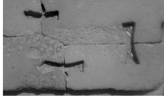
(لوحة ٩) كتل مربوطة بمعبد كوم أمبو باستخدام تشييق ذيل الحمامة. تصوير الباحث
