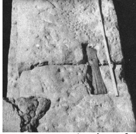
(لوحة ٢٥) تعشيق ذيل حمامة ما زال في موقعه بالمعبد الجنائزي لرمسيس الثالث بمدينة هابو. Hölscher, U., The Mortuary Temple of Ramses III, vol. II, OIP., no. 55, figs. 3
