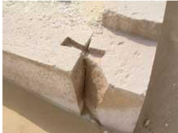
(لوحة ٦) تجويف تعشيق ذيل الحمامة بهرم الملك امنمحات الأول في اللشت،
