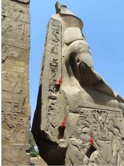
(لوحة ٢٩) تمثال رمسيس الثاني بمعبد الأقصر به تجويفات لتعشيقات ذيل الحمادة
