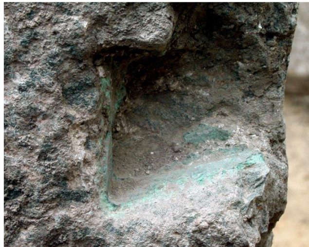
(لوحة ١٦) أثار البرونز المتأكسد بتجويف تعشيق ذيل حمامة، كتلة من البازلت بمعبد نختانبو الأول بتل البلامون Spencer, J., BMSAES. , vol. 4, fig. 7.
