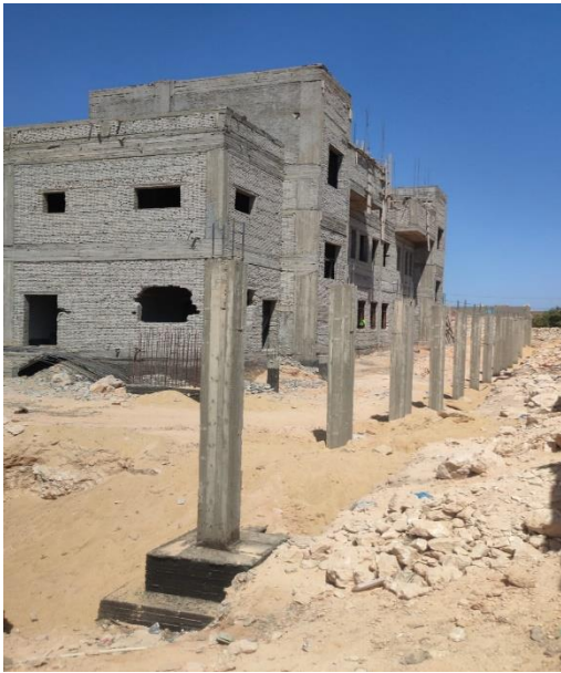
انشاء وحدة إسعاف بنجع احمد بقرية بهيج تم تسليمها ونعمل حاليا
