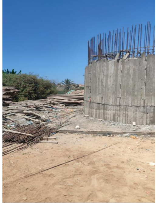
إنشاء محطة صرف صحي ١ بقرية بهيج بهيج
